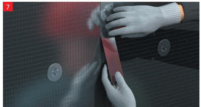
**ВАЖНО!** При применении изоляции с кашировкой стыки необходимо герметизировать при помощи самоклеящейся алюминиевой ленты.
