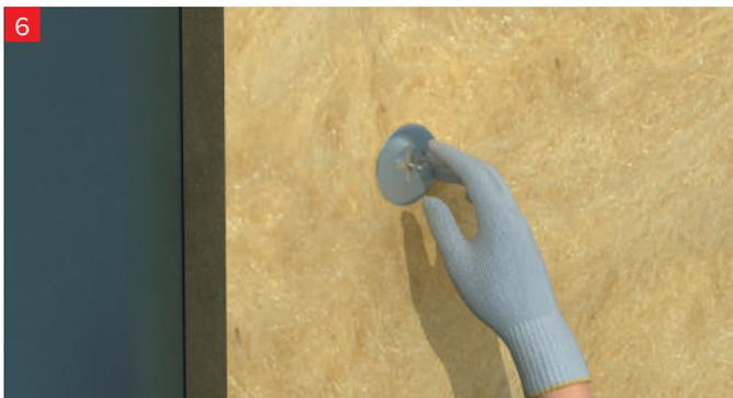
Изоляция фиксируется при помощи стальных шайб.
