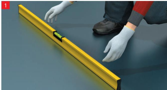
Необходимо проверить ровность основания и в случае, если поверхность волнообразная или имеет значительные неровности, способные привести к излому изоляционной плиты, необходимо устройство выравнивающей стяжки.
