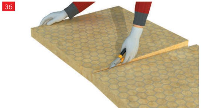
вырезать плиты или маты на 2–3 мм больше проектных размеров.
