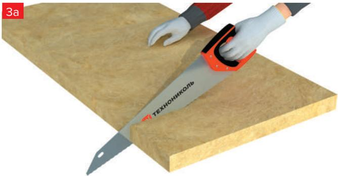
Производится раскрой теплоизоляционных плит или матов. Раскрой можно производить ножом, ножницами или на станке. Рекомендуется
