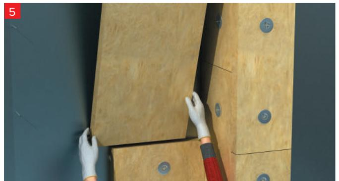
При укладке изоляции между ребрами недопустимо оставлять зазоры. При двухслойной изоляции рекомендуется перекрывать стыки нижнего слоя с разбежкой не менее 150 мм.
